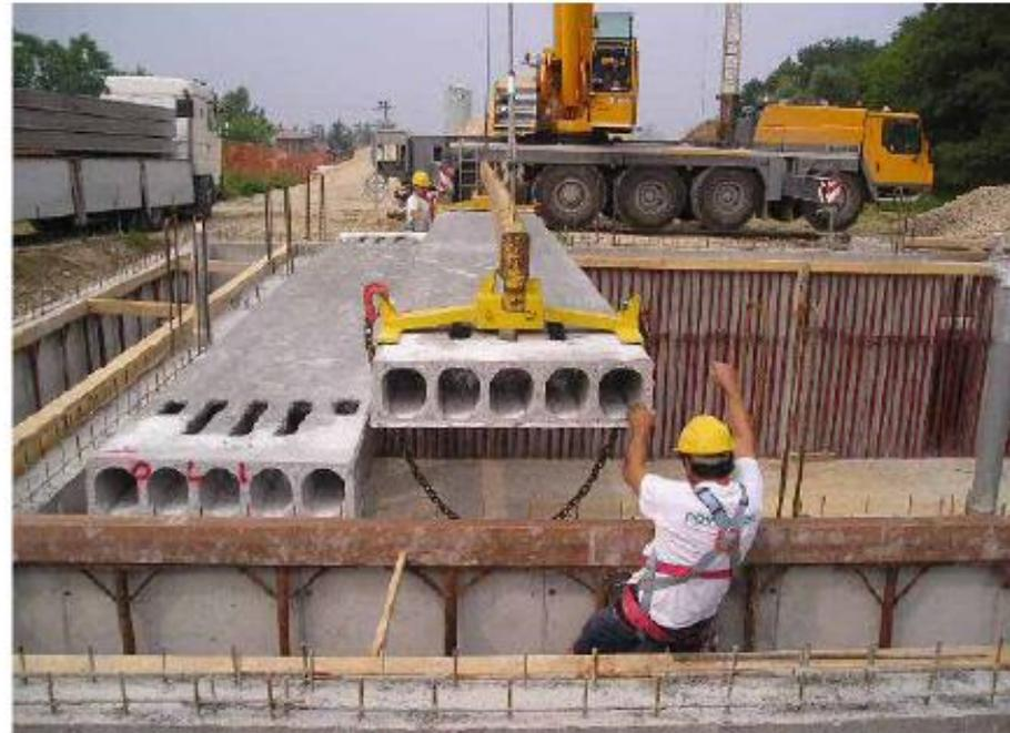
*Elementi portanti (in c.a.p.) a sezione alveolare*
